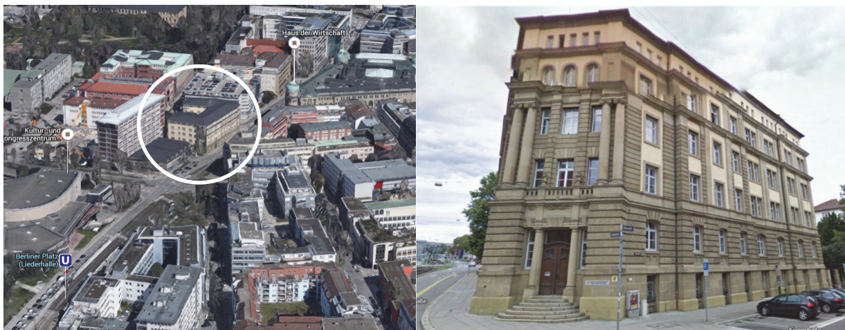
Abb 11: Fallbeispiel 1. links: Canyon-Lage des Objekts), rechts: Ansicht von Ecke Schlossstraße/Kienestraße (Quelle: Google).
